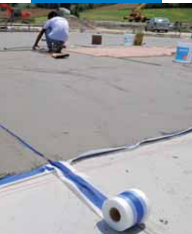
Hydroizolace zhotovená z Mapelasticu a Mapebandu
