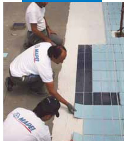
Pokládka keramické dlažby na Mapelastic v bazénu
