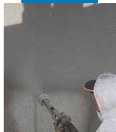
Ukázka nanášení Mapelasticu nástřikem na viadukt
