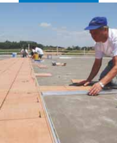
Pokládka keramické dlažby s použitím Kerabondu + Isolastic
