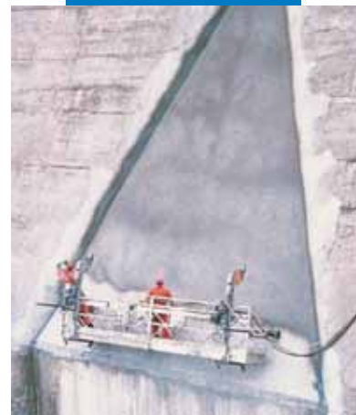
Ukázka nanášení Mapelasticu nástřikem na stěnu přehradu
